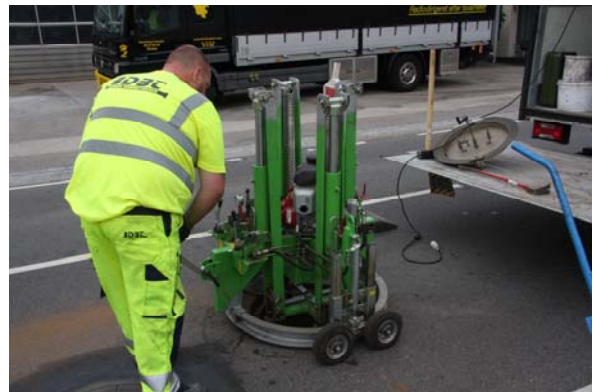
Løftemaskine placeres over brønden
