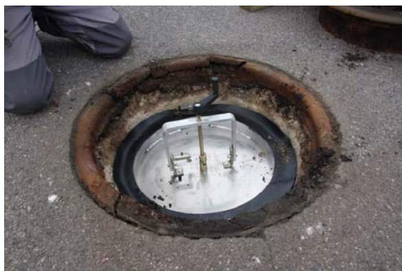
Brønden sikres ,så der ikke falder materiale ned i den.
