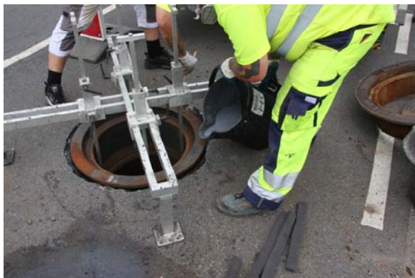
Vergumix Bitulan hældes ned i hulrummet mellem karm og asfalt
