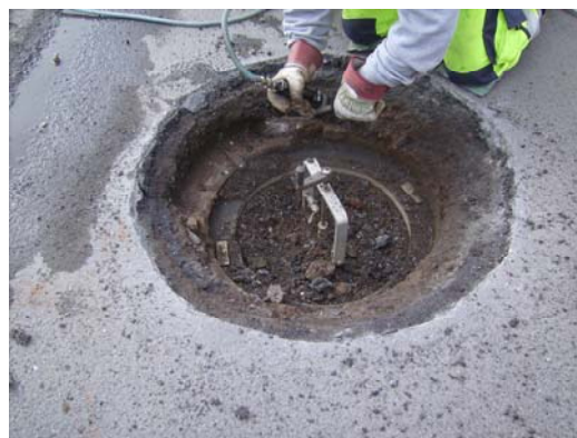
Porøs asfalt fjernes og der laves en konus i asfalten
