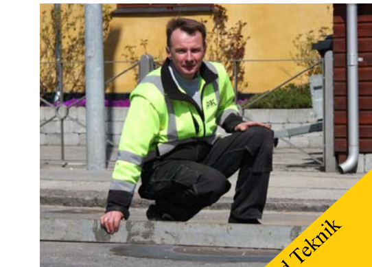
Det kontrolleres, at karmen sidder i den ønskede højde
