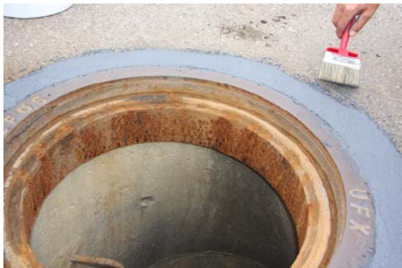
Der laves finish af overgangen
