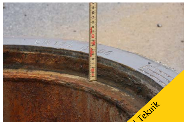
Karm og dæksel kontrolleres for slid og revner
