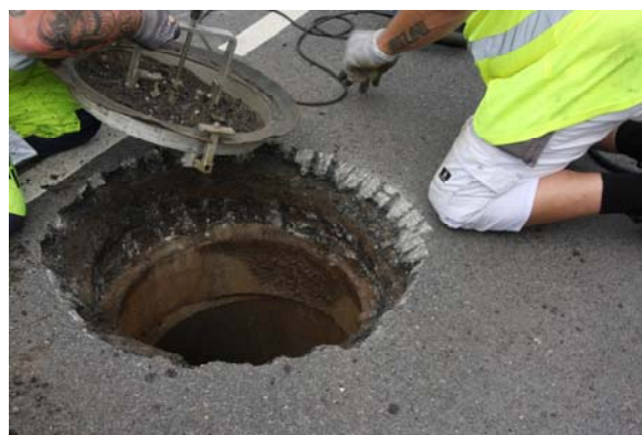
Sikrings dækslet fjernes
