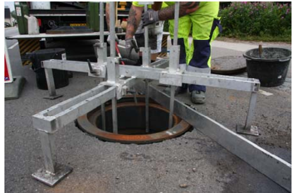
Karmen sænkes ned i niveau med asfalten
