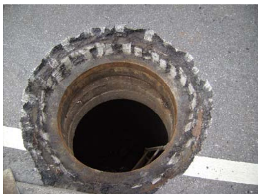
Det kontrolleres at overkanten af brønd karmen er afrenset så tætnings ringen slutter tæt
